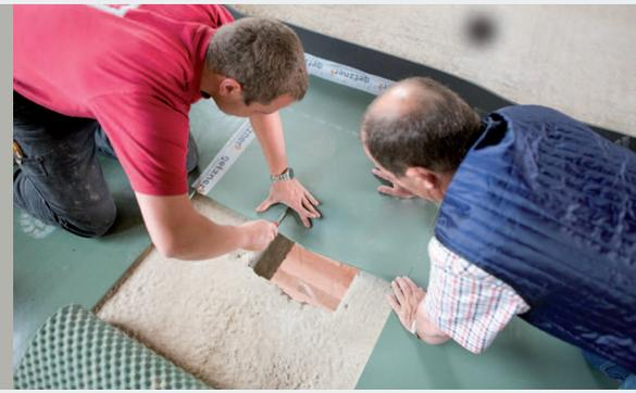
Die Construction Mat von Getzner Werkstoffe ist eine hocheffiziente und wirtschaftliche Lösung zur Reduktion von Trittschall im Hochbau. Der Werkstoff besteht zu einem sehr hohen Anteil aus recyceltem PUR.
