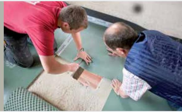
Le matelas acoustique de Getzner Werkstoffe est une solution hautement efficace et économique de réduction des bruits d'impact destinée au secteur du bâtiment. Ce matériau contient une proportion très élevée de polyuréthane recyclé.
